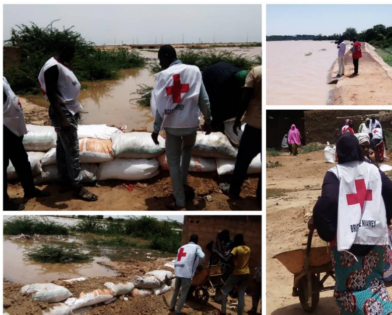
Photos de la visite de suivi de la crue du fleuve et l'activation test du mécanisme FbF, août-septembre 2019, en réponse aux inondations de fin août 2019. On voit ici la réalisation d'une digue de protection fait à l'aide de sacs de sable, qui a été bénéfique à 100 ménages.
