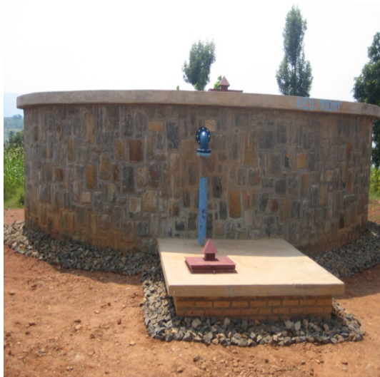
Réservoir de 100m 3
